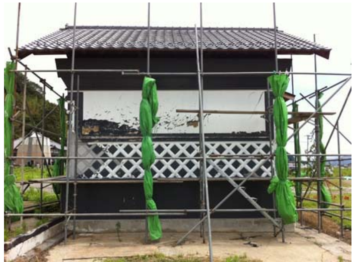
2013年7月23日 北側角の破損の左官 壁の傷の一部はそのままとする 西面
